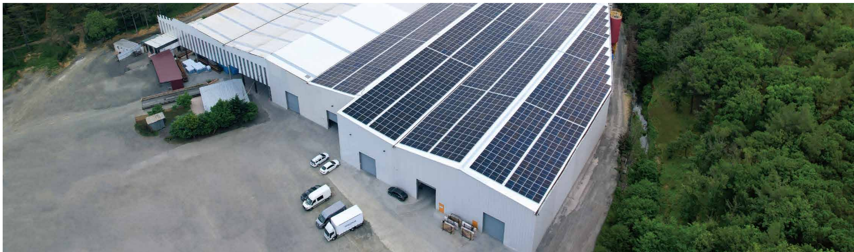
04 Redução de Custos de Energia para Fábrica de Água Mineral Turquia, 900kW KSG-120CL-M0
